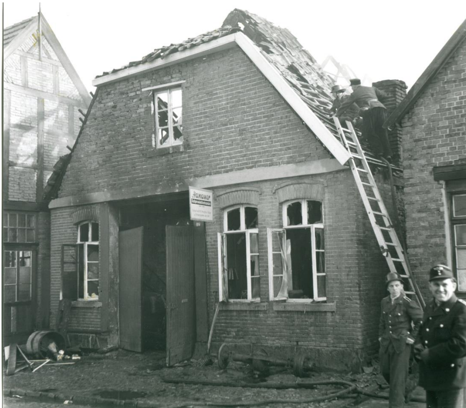
Abgebranntes Haus mit Gustav Hanauers Betrieb in der Schlachterstraße (Foto: Stadtarchiv Lingen)
